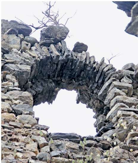
Ein Rundbogen-Fenster am Nordannex mit einem sich in Auflösung begriffenen Mauersturz im Bestand.
