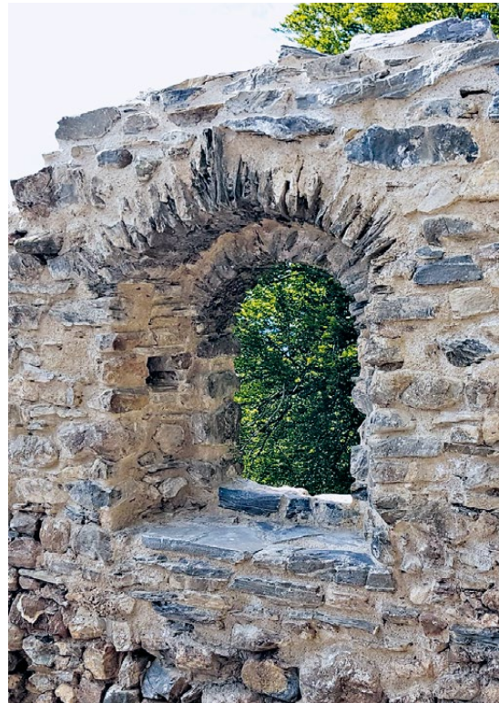
An diesem Rundbogen-Fenster wurde der Sturz stabilisiert und übermauert, zudem wurden gefundene Details wie der Sperrbalkenkanal ebenfalls wieder deutlich ausgebildet und erhalten, wie auch der gesamte Brüstungs- und Leibungsbereich.
