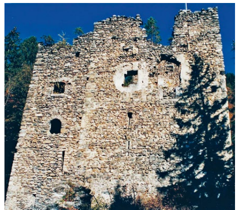
Dieselbe Ansicht nach der Konservierung, Unterfangung, Übermauerung.
