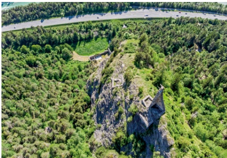
Das Speerwerk Juvalt versteckt sich zum grössten Teil unter der Ruine Hochjuvalt.
