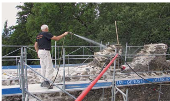
Florian Kunfermann beim Nachnässen der fertig gesicherten nördlichen Mauerkrone.
