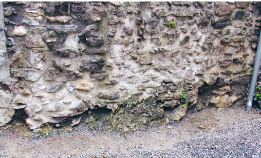
Nach der Rohplanie und Einkiesung des Bodens im älteren Wohnbau kamen in einer der ersten vom lokalen Baumeister konservierten
