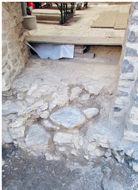
(links) trittsicher, aber dennoch bewusst nicht als Treppe ausbildeten (rechts).
