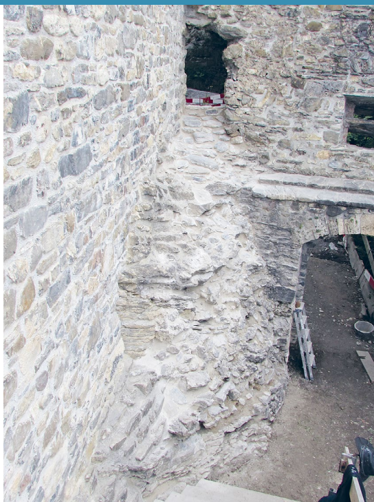
ger wurde von Bewuchs freigelegt und neu wasserabschlchtig konserviert.
