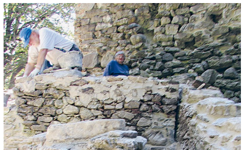
enthusiasmisiert (links) und bis auf einen tragfähigen Mauerkern zurückgebaut und neu übermauert sowie der Bestand verfestigt und konserviert werden (rechts).
