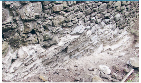
Diese mauertiefe Ausbruchstelle in der Sockelzone an der Nordwest-Fassade des jüngeren Wohnbaus musste mit mittelalterlichem Mauerwerk tragend unterfangen werden.
