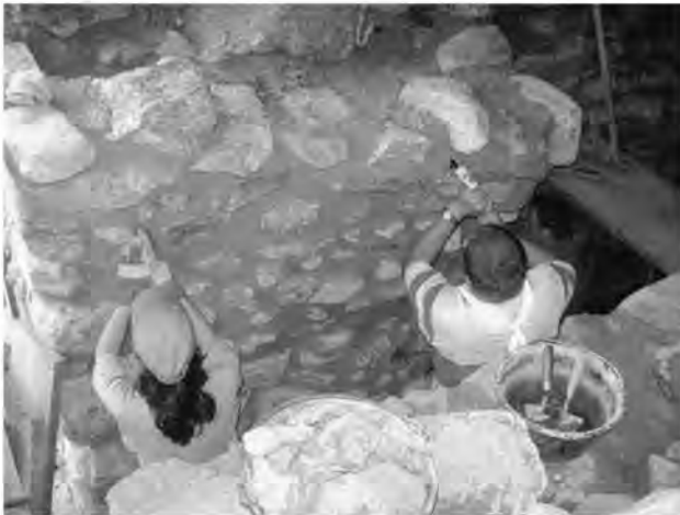
Isabelle Finsterwald und Hucky Gysel beim Nachbearbeiten des am Vortag erstellten „Pietra-rasa“-Fugenfinish (Foto W. Schläpfer)
