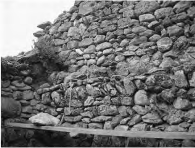
Bei den sorgfältigen Kronen-Freilegungsarbeiten kam dieser doppelstufige Mauerrücksprung (Balkenaufleger) auf der bergseitigen Mauerseite zum Vorschein, schematisch nachgebildet mit dem Doppelmeter. (Foto W. Schläpfer)
