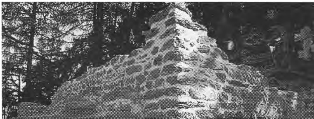
Ansicht der sanierten Westmauer von Balcun At (Foto BVG)
