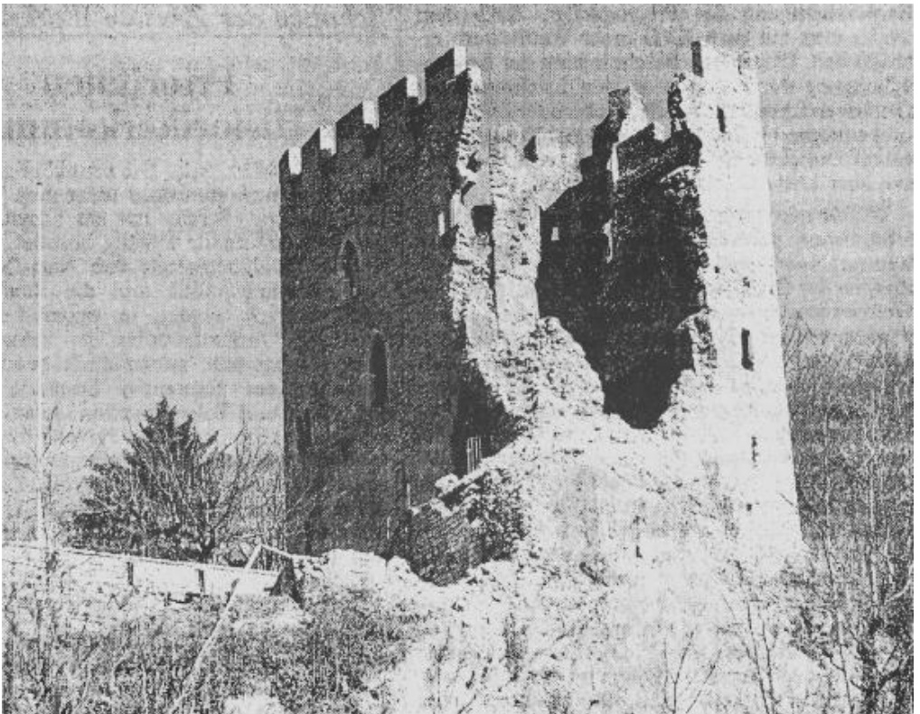
Die Südwand der Burg Neu-Thierstein in Büsserach SO ist Anfang März 1997 abgestürzt - zum Glück in der Nacht, als keine Besucher auf der Ruine weilten. Ein Wiederaufbau der stolzen Anlage wird derzeit diskutiert. (Foto key, NZZ vom 10.3.1997)
