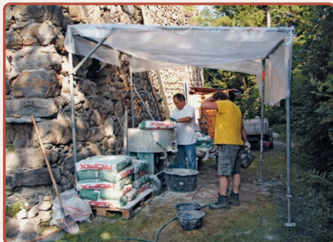
Ohne Mörtelmischer geht gar nichts.
