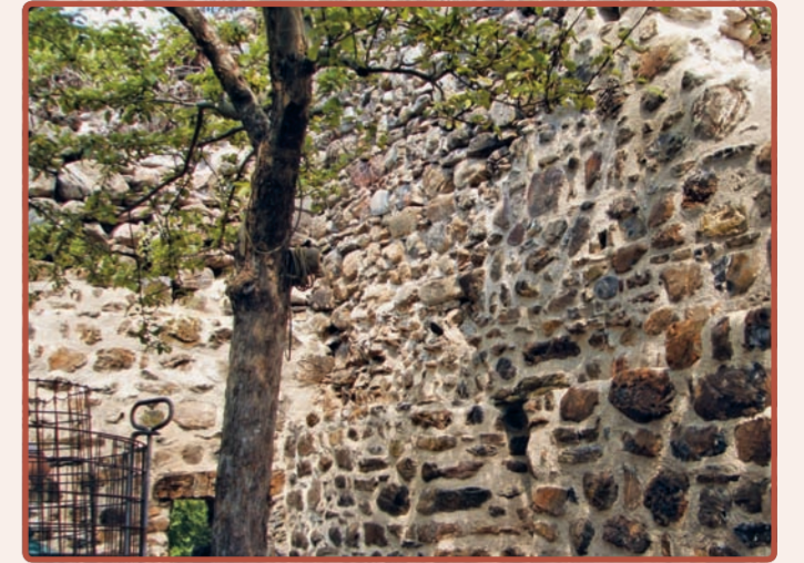
... der vollständig restaurierte Zustand.
