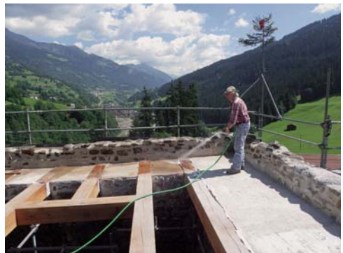
Gut sichtbar: die eingemauerte Dachbalkenlage samt ruinenhaft ausgebildeten Brüstungsmauern (Foto BVG)
