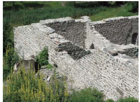
Südwestecke der sog. Zollstation der Unterburg von Hochjuvalt/Niederjuvalt in gesichertem Zustand, links ein Betonhöcker des ans mittelalterliche Gemäuer anschliessenden neuzeitlichen Panzerhindernisses (Foto BVG)
