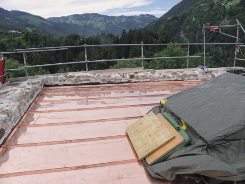
Das mit Kupfer verkleidete Schutzdach auf dem Turm von Strahlegg; rechts das noch abgedeckte, kaum einsehbare Fenster als Lichtquelle und Ausstiegs Luke (Foto BVG)
