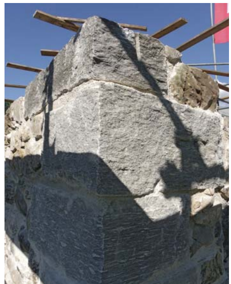
Die zuoberst neu aufgemauerte Südwestecke des Turms. (Foto BVG)
