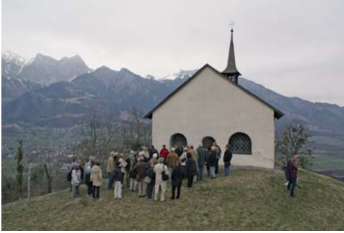
Die kleine, ursprünglich gotische Kapelle St. Georg mit Blick auf die Bündner Herrschaft.
