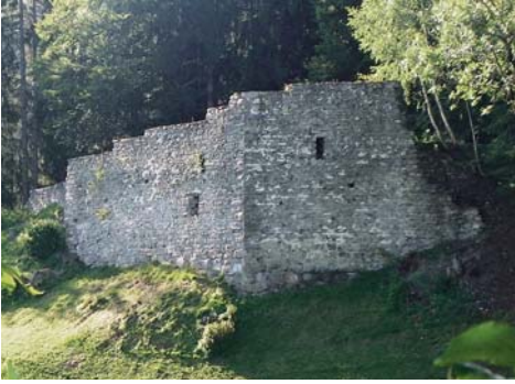
Eine von Schülern unterstützte Forstequipe befreite die grosse Mauer von Kapfenstein von dem sie teils verdeckenden Bewuchs. (Foto BVG)
