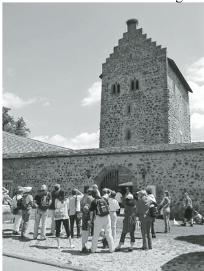
Burg Riedheim: nicht alles daran ist echt, aber der Gesamteindruck stimmt. Im Fokus ist hier ausnahmsweise nicht der schöne Wohnturm, sondern der Jungstorch im Nest.
