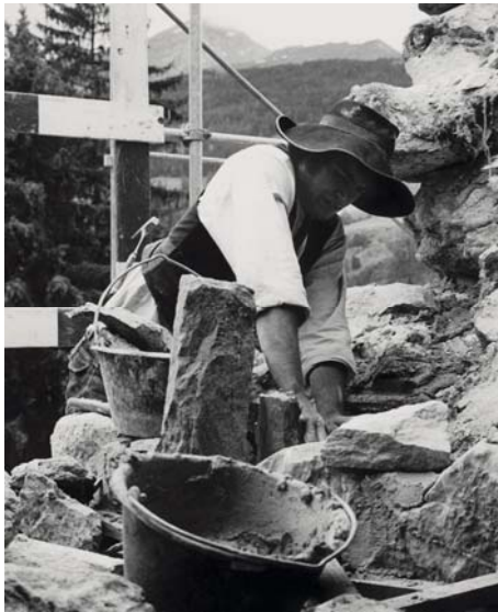
Ivo Tognella beim Setzen einer Licht- und Luftscharte. Ein zünftiger Zimmermann beherrscht eben auch den Umgang mit Mörtel und Kelle, besonders wenn er Walter Schläpfers Göttibub ist! (Foto Martin Wegmann, BVG)
