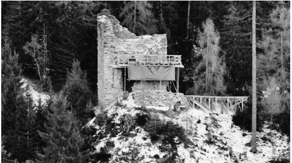
Ansicht der Burg von Nordwesten mit Materialplattform (rechts) und Arbeitsbühne; vorne verdeckt der riesige Ausbruch (Foto BVG)
